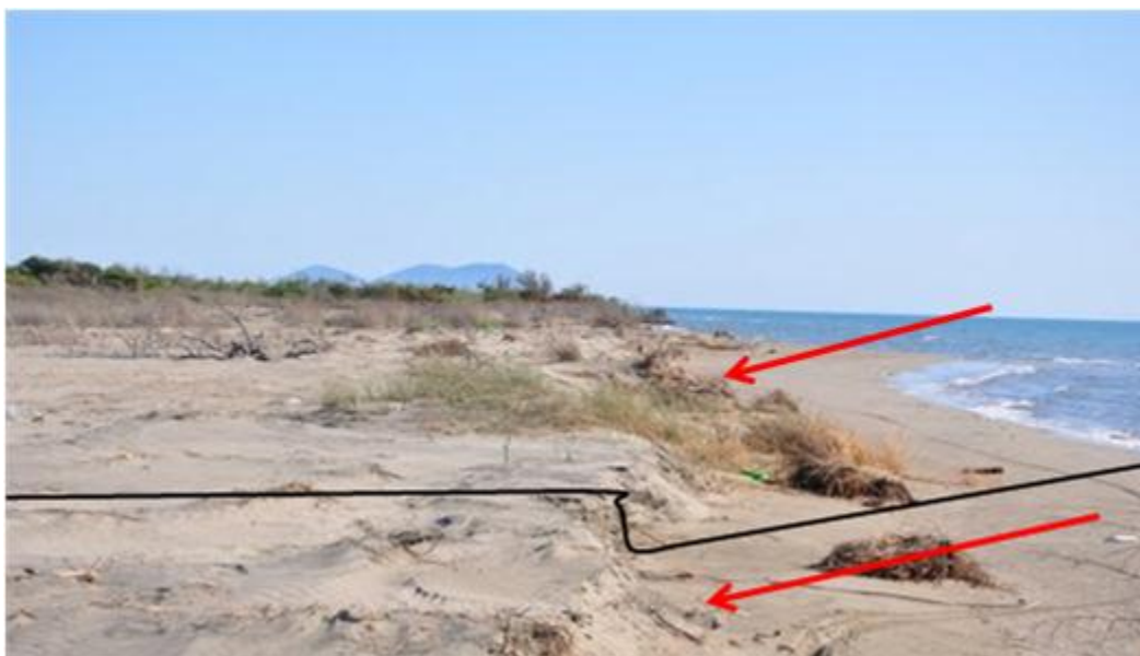
Fig.V.26. Pamje nga bregdeti në krahun e djathtë të deltës së Vjosës. Erozioni ka prekur sektorë të gjerë në veri të saj.
